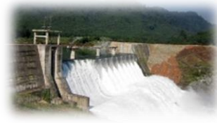
Dak Mi 3: 63 MW
